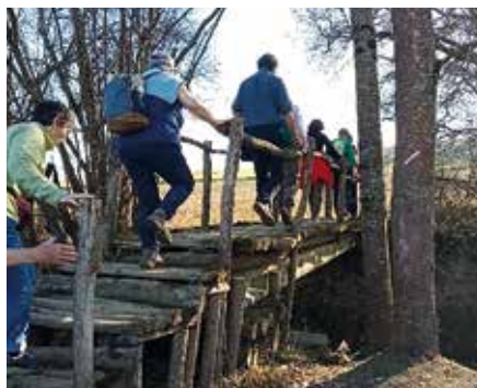
Passerelle de Ste-Foy-de-Peyrolières avant son remplacement
