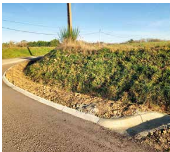
Renforcement de la voie communale 7 à Beaufort
