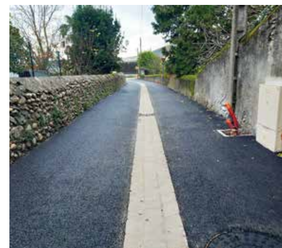
Rénovation rue du stade à Martres-Tolosane
